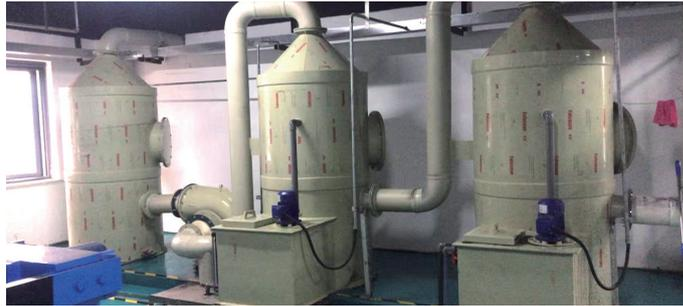
北京工廠污水處理系統採用廢氣無害化處理方式
